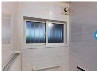
内窓設置:マドリモ 内窓 プラマードU
